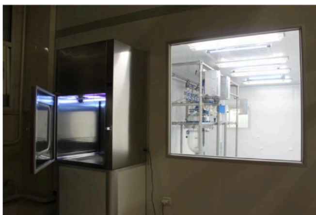
Рисунок 2 – Смотровое наружное окно и шлюз для передачи материалов в чистое помещение
